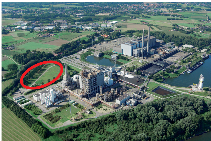
In Buggenum, bij Roermond, staat een elektriciteitscentrale van Vattenfall-NUON die gebruik gaat maken van de CCS-technologie. Bij de rode cirkel wordt een CCS-installatie gebouwd.
